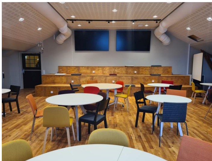
Bild 7 Scen/sitttrappa med stomme av EU-pallar och ytskikt av salens återbrukade stolsryggar.
