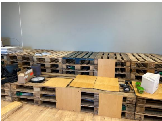
Bild 9 Under renoveringen syns scenens stomme som är gjord av EU-pallar och ytskikt som är gjort av återbrukade stolsryggar.
